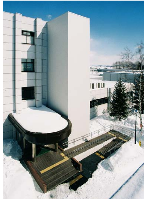
増築された社会環境工学科2号棟エレベーター
