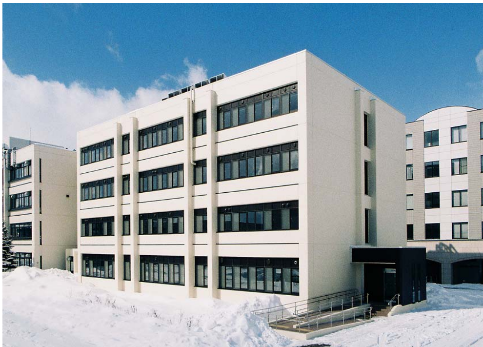
改修を終えたバイオ環境化学科2号棟
